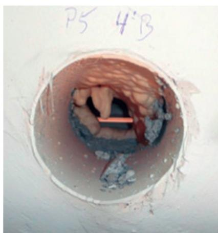
Foto 6.6. Yeso, aislamiento y escombros en el tubo de admisión de aire de una unidad descentralizada en fachada.
