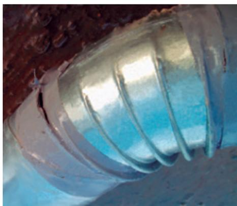
Foto 6.7. Fuga de aire que provocará: disminución del caudal, menor eficiencia energética y ruido.
