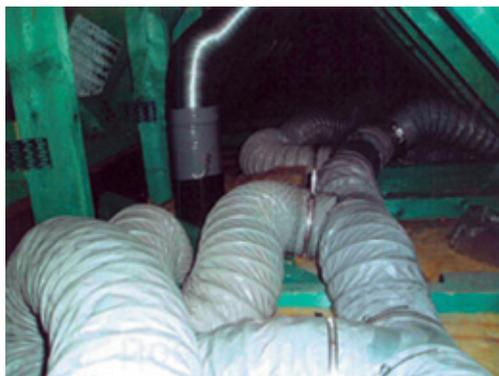
Foto 6.5. Conductos flexibles con T's y muchas curvas.
