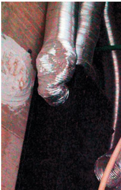
**Foto 6.8.** Unidad de extracción de aire mal conectada debido a: disminución de la sección, curva forzada e instalación en tubo flexible sin estirar y de más de 0,5 m.
